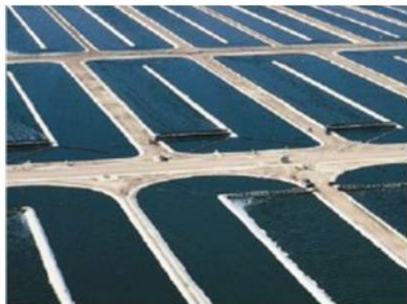
Abb. 2: Raceway Reaktoren: 600 ha Earthrise Open Pond Anlage in Amerika
